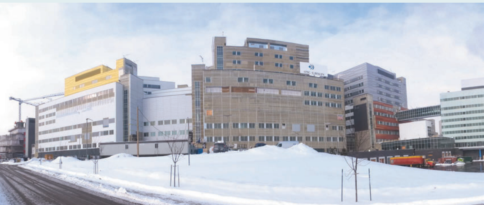
Notre nouveau toit : l'édifice jaune à gauche est le nouvel HME!
