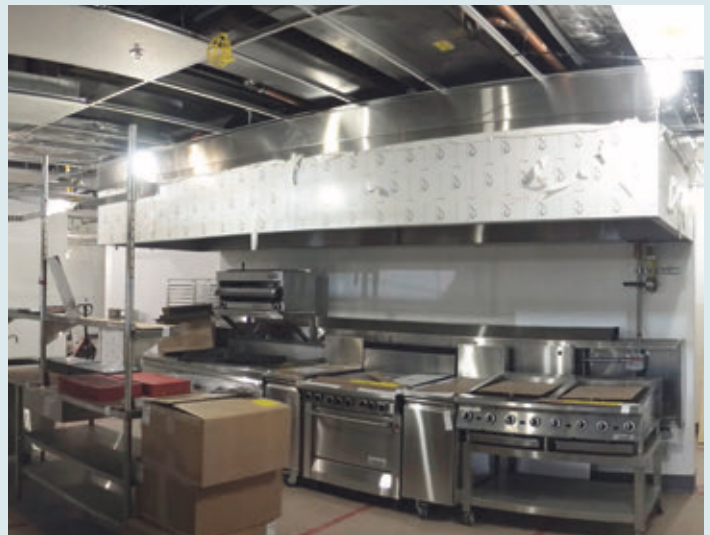
La cuisine progresse bien! Les services alimentaires sont situés au D-S2.
